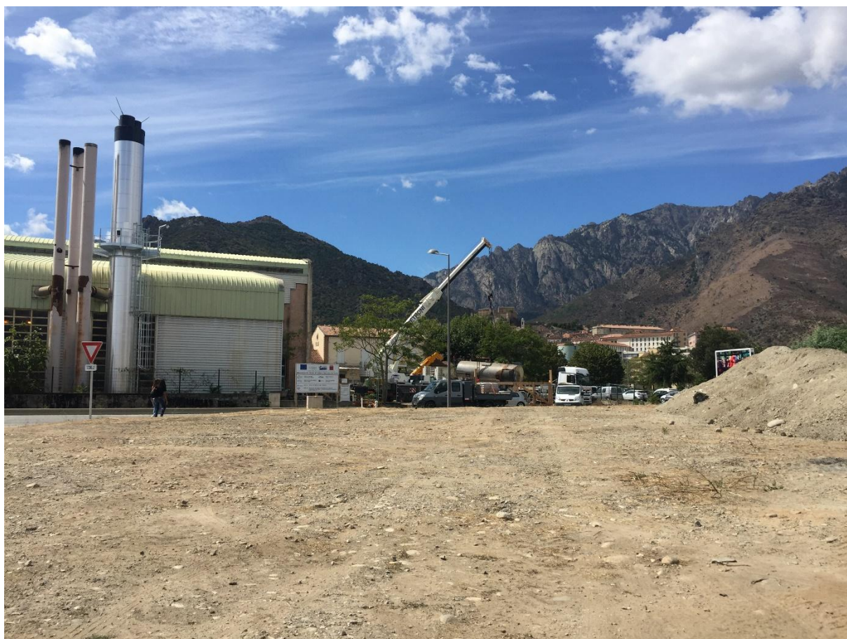
Figure 18 : Centrale à bois de Corte lors des travaux de rénovations Source : Qualitair Corse
