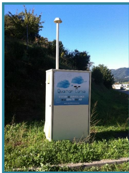
Figure 3 : Station mobile installée sur le site 3 du transect (Source : Qualitair Corse).
