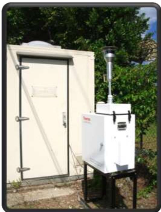
Préleveur installé à La Marana
