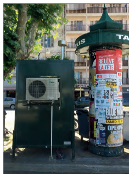
Figure 42, 43, 44 - Différentes prises de vues de la nouvelle station d'Abbatucci.
