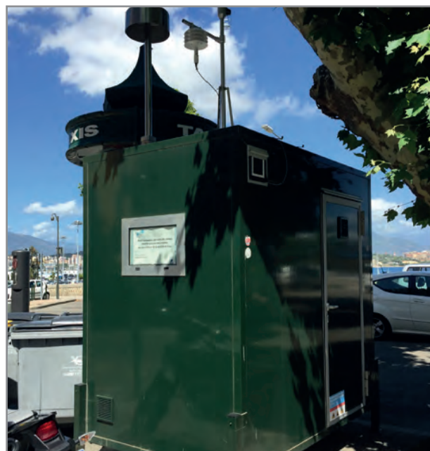
Figure 17 - Nouvelle station de mesure "trafic" installée sur la place Abbattucci
