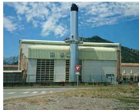
Figure n°35 - Photographie de la chaufferie bois à Corti après sa rénovation (source : Qualitair Corse)
