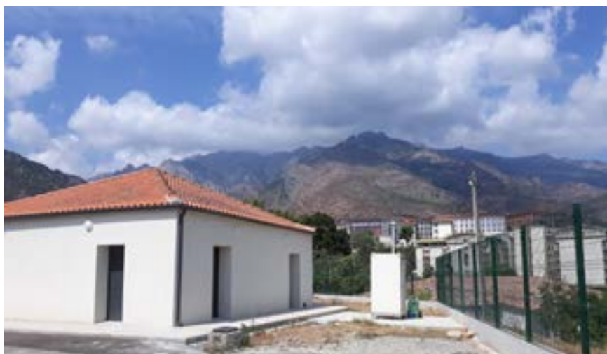
Site de surveillance de Corte situé à la maison du temps libre
